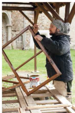
▲ Odborná repase okenních křídel hlavního sálu na zámku Brtnice. Foto Václav Malý
