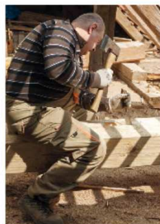
▲ Oprava krovu na zámku Brtnice – ruční výroba tesařských spojů. Foto Viktor Mašát
