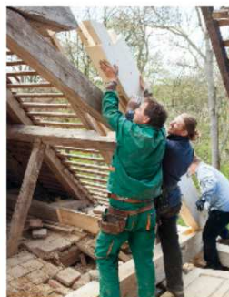
▲ Náhrada poškozených částí krovu při použití tradičních celodřevěných spojů na zámku Brtnice. Foto Viktor Malý
